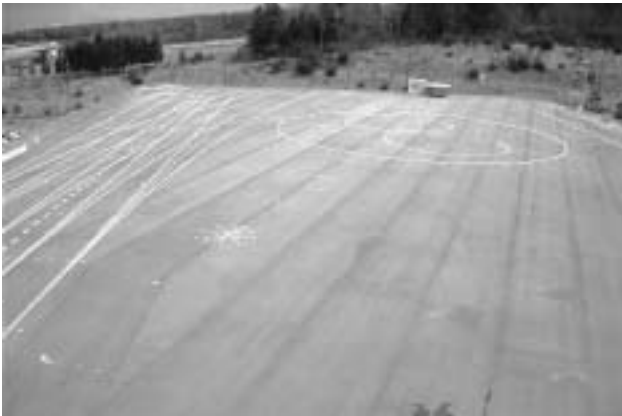
図-5 屋外試験場全景
