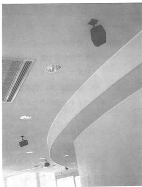
図-11 ハウジングオーディオ 施工例 Fig. 11 Typical installation of the housing audio
