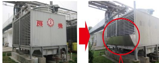
クーリングタワーの冷却水が、循環時に外に漏れやすい構造になっていることがわかったため、冷却水の漏えいを防止するカバーを設置する改良を行いました。
